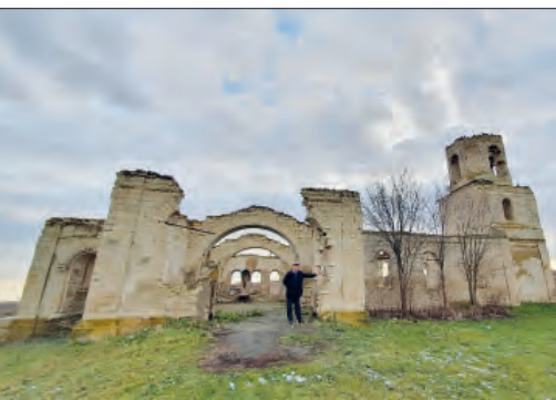
Рис. 3. Разрушенная церковь иконы Божией Матери «Одигитрия» в Ростовской области, сложенная блоками из карбонатных опоковидных пород, находящаяся без крыши более 60 лет
