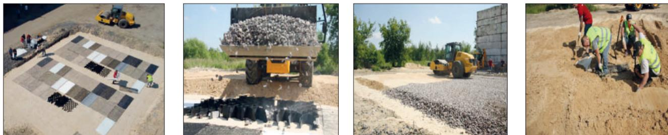
Рис. 2. Общий вид испытательного полигона с размещением геосинтетических материалов, засыпкой, уплотнением и извлечением
